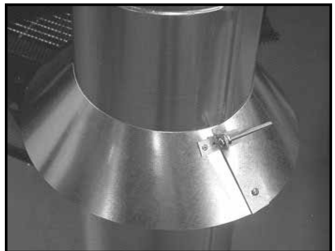
Figur 46. Sammensetting av stormkragen rundt røret
