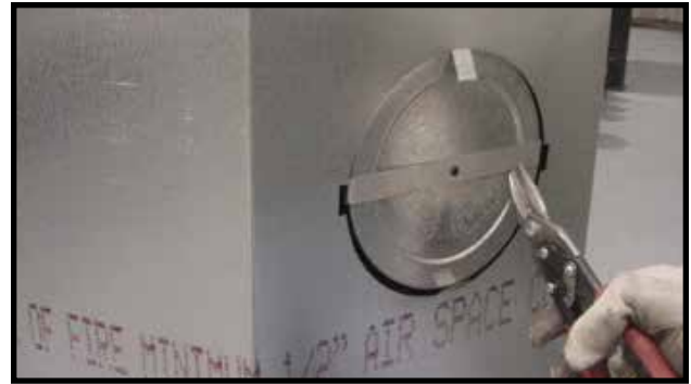
Figur 24. Kutt metallbåndet og bøy sidene utover.
