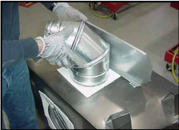
Figur 22. For å feste den første delen av avtrekksrøret må glassfiberpakningen brukes. Dette for å gjøre det tett mellom den første avtrekksdelen og den ytre kassen. Bruk 2 mutterløse skruer til å feste pakningen til kassen.
