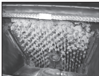
Figure 27.1 – Exemple d'échangeur de chaleur sale
