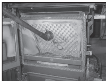
Figure 27.1 – Exemple d'échangeur de chaleur sale
