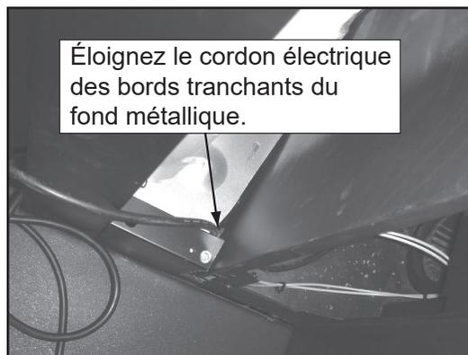
Figure 12.4. Placez le foyer encastré dans la boîte à feu préfabriquée. Assurez-vous que le cordon électrique ne puisse pas être endommagé par le bord métallique tranchant. Vous devrez peut-être découper une encoche pour le cordon.
