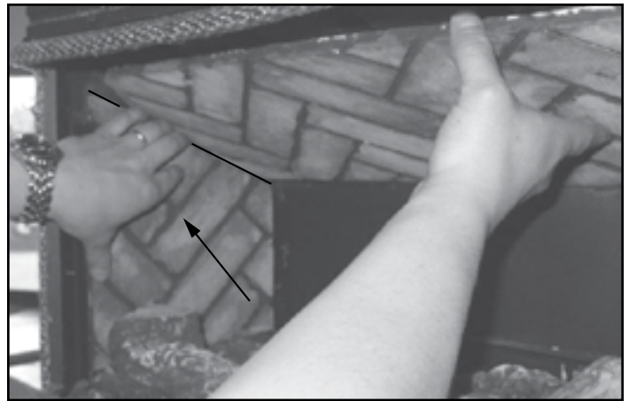
Figure 8.14 - Tout en maintenant le déflecteur en place, installez la brique gauche dans sa position.
