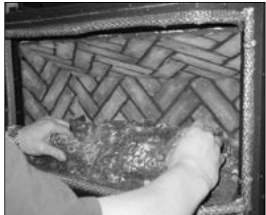
Figure 6.2 Soulevez le brûleur hors de l'ouverture du foyer.
