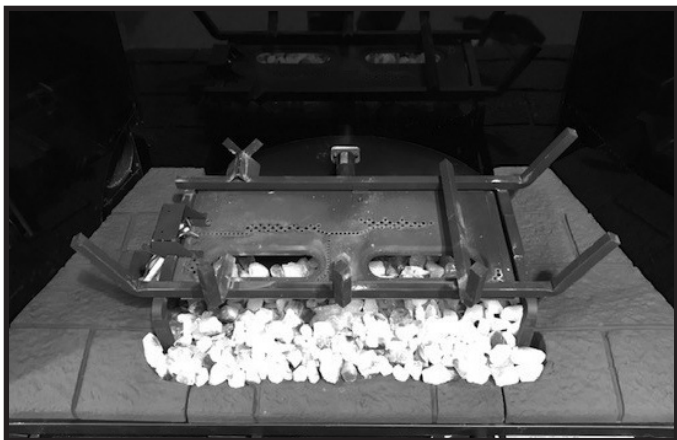
Figure 11.11. Positionnement du Teco-Sil
