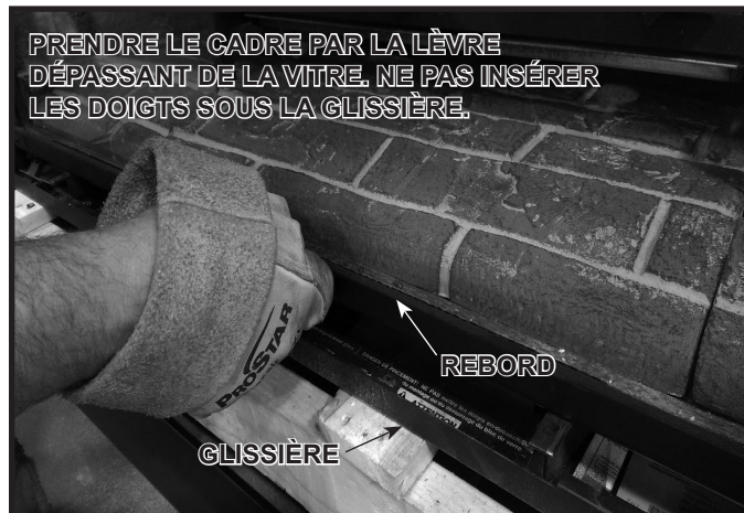
Figure 11.6. Installer la vitre
