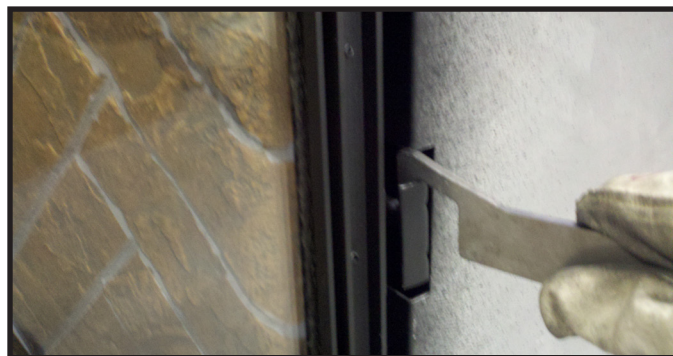
Figure 11.7. Sécuriser les clips de vitre latéraux
