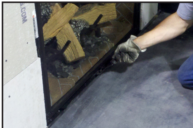
Figure 11.8. Sécuriser les clips de vitre inférieurs
