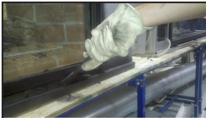
Figure 11.3. Insérer l'outil du clip de vitre
