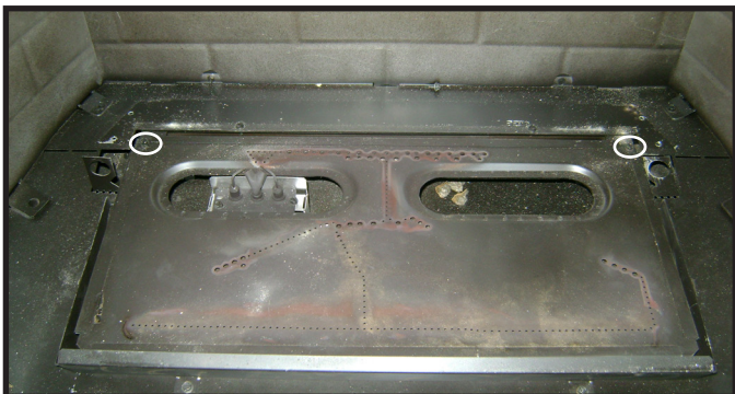
Figure 4.9 Retirer les vis des coins arrière du brûleur
