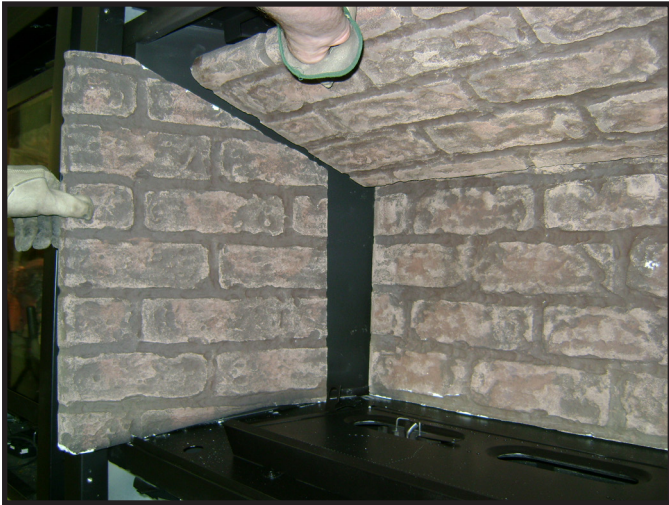
Figure 4.3 Démontage du réfractaire supérieur
