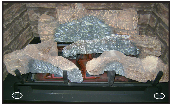
Figure 4.7 Retrait des vis des languettes frontales
