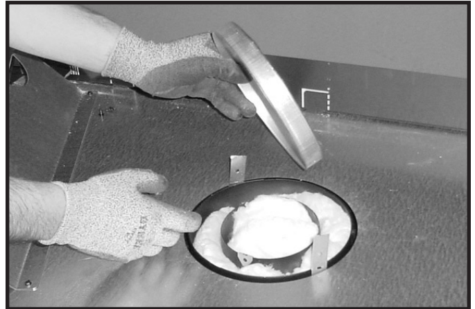
Figure 6.3 (représentation d'un foyer générique) Enlevez le couvercle du conduit.
