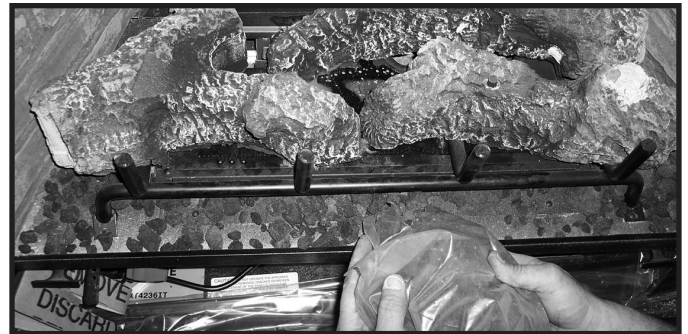
Figure 11.4 Placement de la pierre de lave
