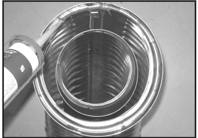
Figure 7.1 Scellant de silicone à haute température
