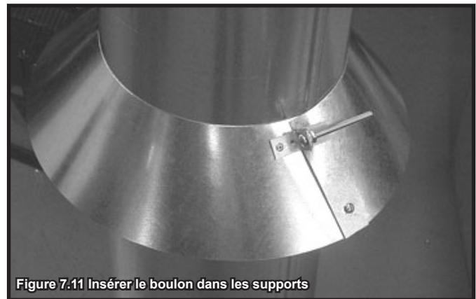
Figure 7.11 Insérer le boulon dans les supports
