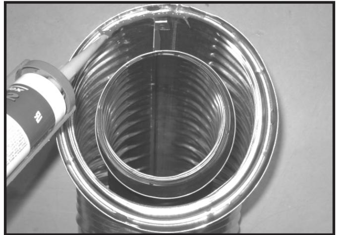
Figure 7.1 Scellant de silicone à haute température
