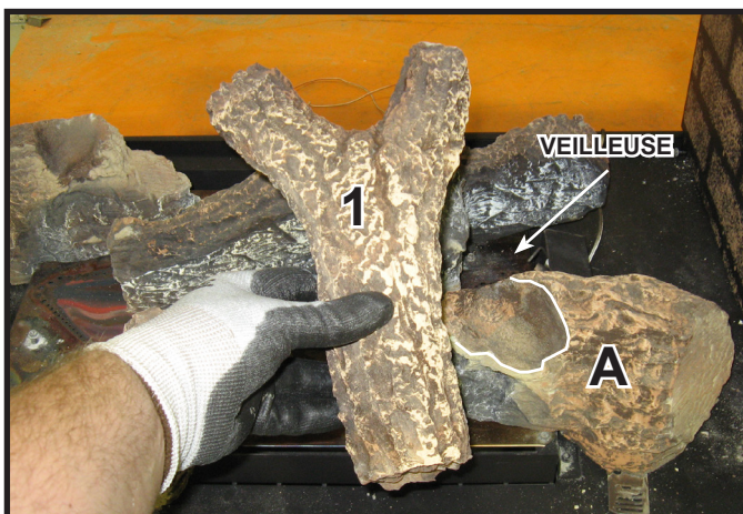
Figure 3. Pose de la bûche n° 1
