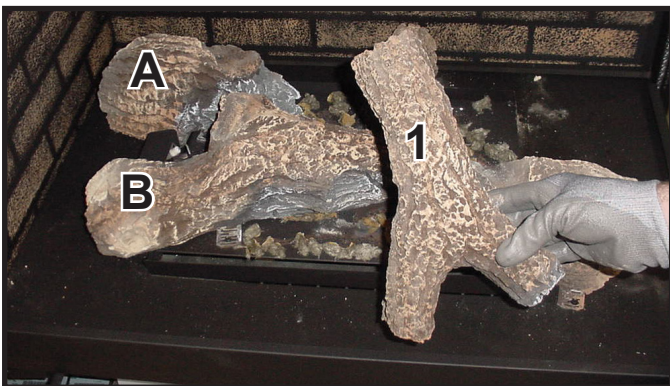
Figure 9. Pose de la bûche n° 1
