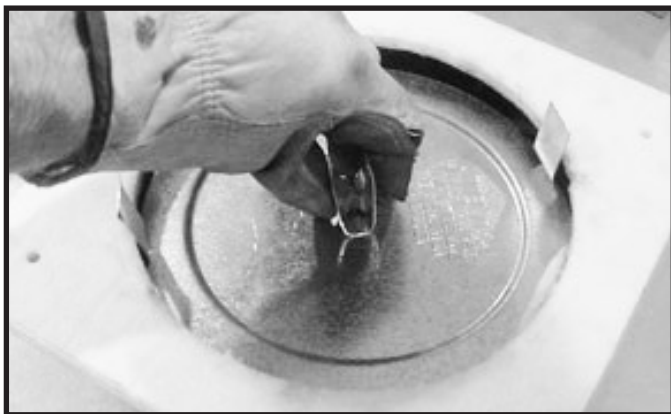
Figure 6.2 Replier les parties centrales de la bande de retenue vers le haut et les utiliser pour enlever le couvercle du conduit d'évacuation.
