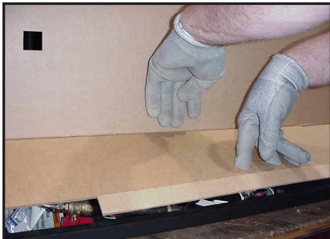
Figure 11.9 Ouverture d'un panneau d'accès inférieur
