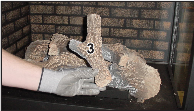
Figure 13. Pose de la bûche n° 3
