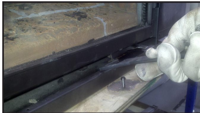
Figure 11.2 Emplacement de l'outil du clip de vitre
