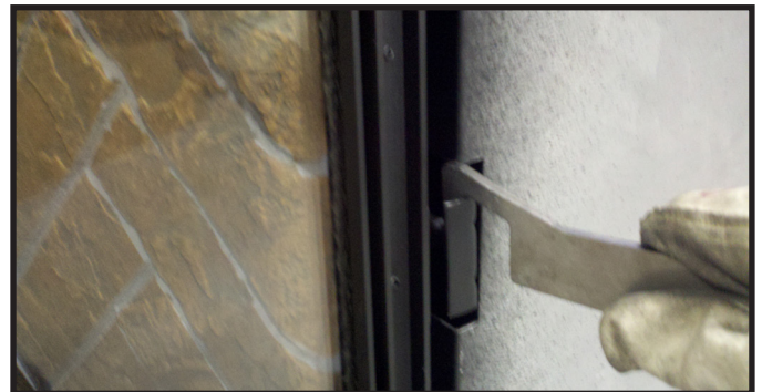
Figure 11.7. Sécuriser les clips de vitre latéraux
