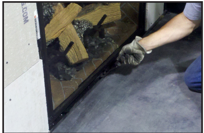
Figure 11.8. Sécuriser les clips de vitre inférieurs
