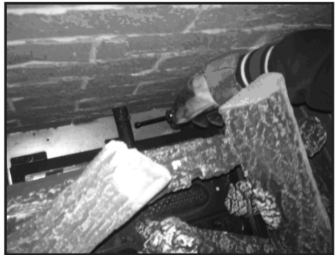
Figure 1. Emplacement de l'obturateur d'air
