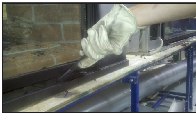
Figure 11.3. Insérer l'outil du clip de vitre
