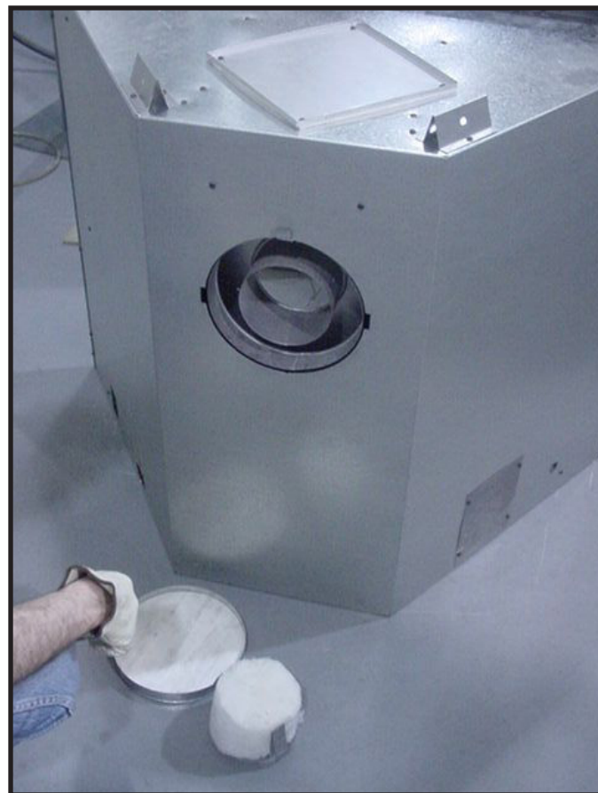
Figure 6.9 (représentation d'un foyer générique) Jetez le couvercle du conduit, enlevez et jetez le panier d'isolant.
