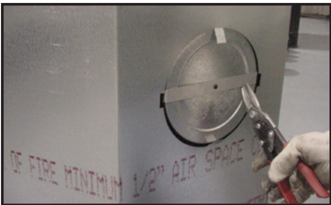
Figure 6.7 (représentation d'un foyer générique) Coupez la bande métallique de retenue et pliez les deux parties coupées vers l'extérieur.
