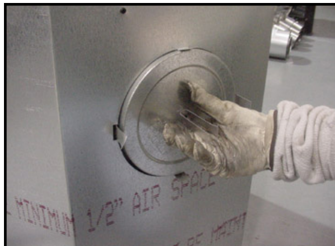
Figure 6.8 (représentation d'un foyer générique) Repliez vers l'extérieur les parties centrales de la bande de retenue et les utiliser pour enlever le couvercle du conduit.
