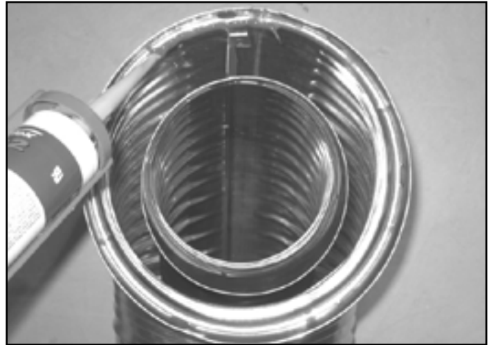
Figure 7.1 Produit d'étanchéité à la silicone haute température
