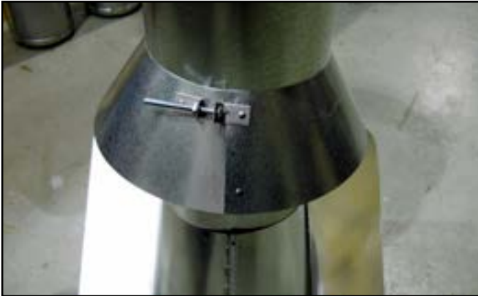
Figure 7.14 Insérer le boulon dans les supports
