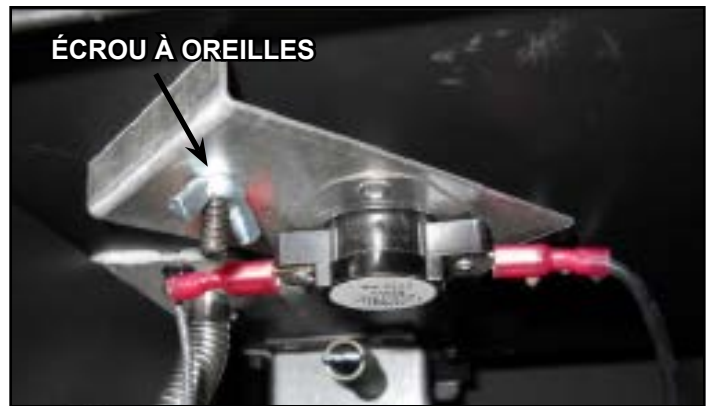
Figure 8.5 Interrupteur à capteur de température installé
