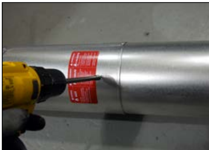
Figure 7.4 Vis sur la section coulissante
