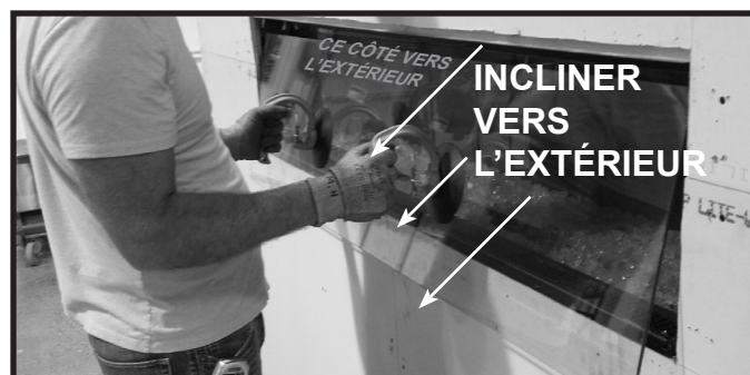
Figure 4.2 Incliner et retirer l'écran de verre
