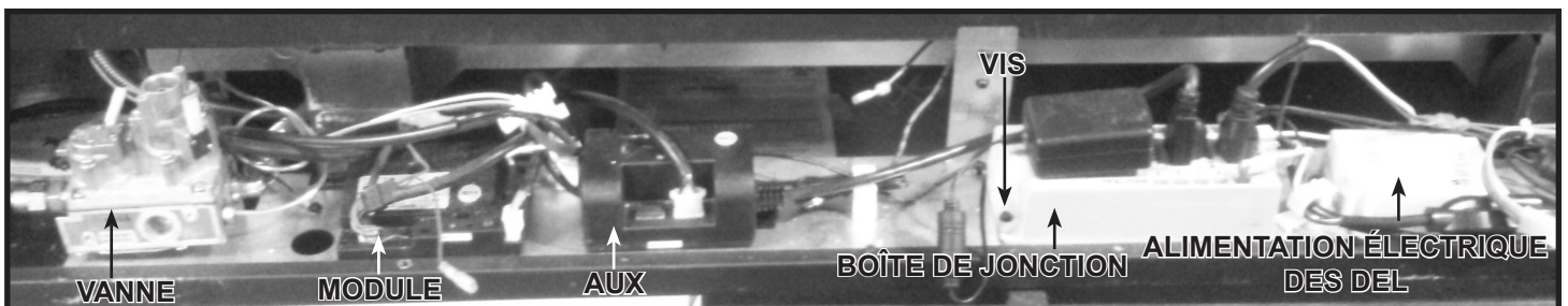
Figure 8.4. Cavité de la vanne (panneau protecteur de l'accès inférieur retiré)
