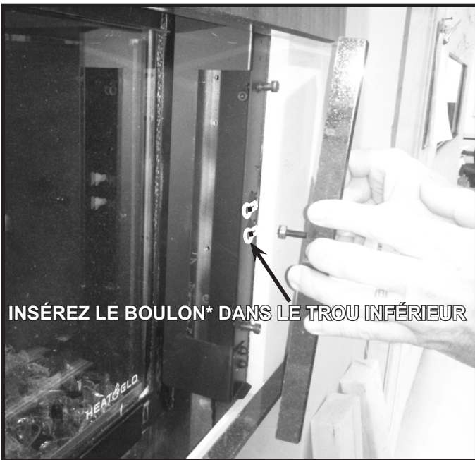
Figure 10.25. Installer les pièces latérales de granite
