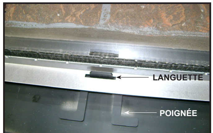
Figure 11.4 Onglet de verrouillage engagé dans le cadre
