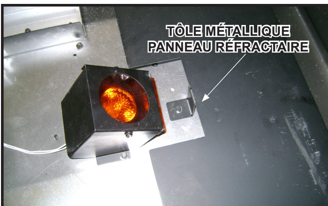
Figure 11.13 Installation de l'éclairage décoratif une fois terminée
