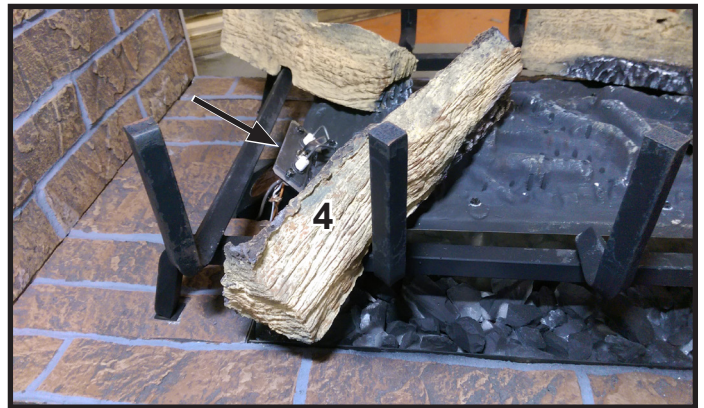
Figure 11. Vue latérale rapprochée de la bûche n° 4 montrant la rainure touchant la grille.
