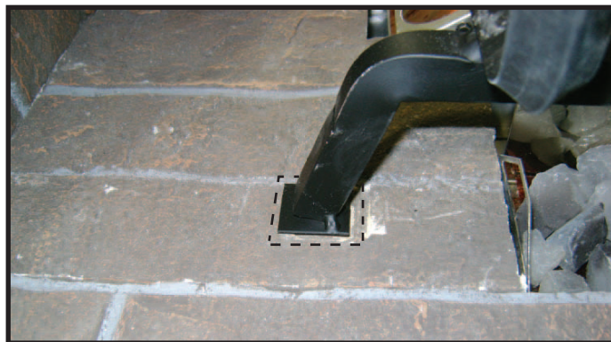
Figure 3. Disposition du pied de la grille.
