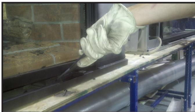
Figure 11.3. Insérer l'outil du clip de vitre
