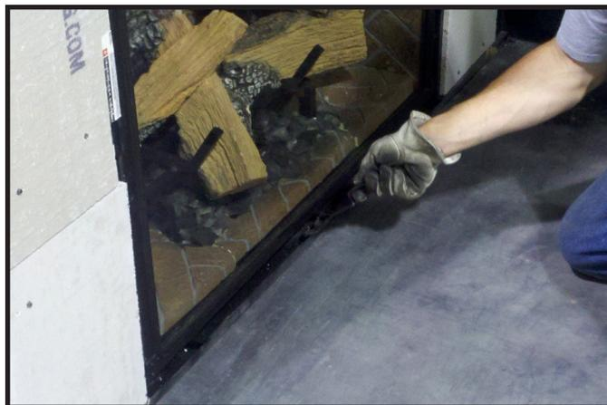
Figure 11.8. Sécuriser les clips de vitre inférieurs
