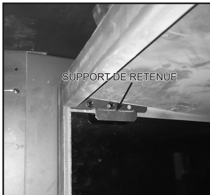
Figure 5 Installation du support de retenue - Panneau latéral
