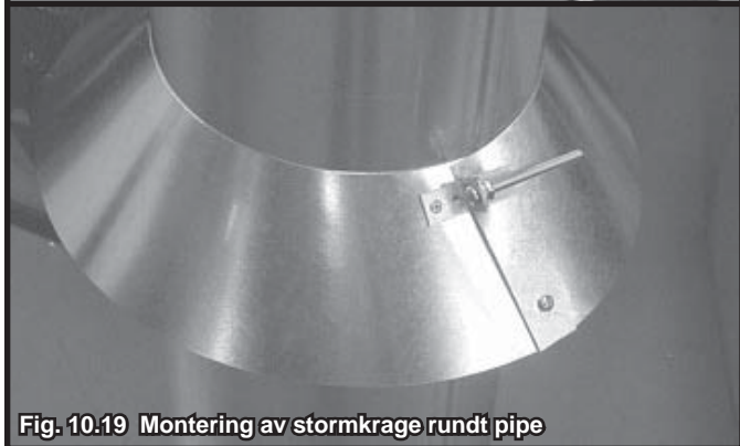
Fig. 10.18 Montering av stormkrage
