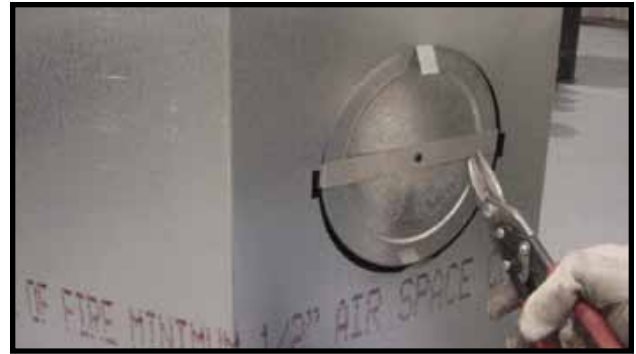
Figur 24. Kutt metallbåndet og bøy sidene utover.
